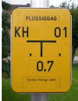
Abb. 22: Hinweisschild für einen Flüssiggas- schieber
