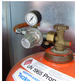
Abb. 5: Absperrventil mit Sicherheitsventil und geschlitzter Überwurfmutter der Anschlussleitung
