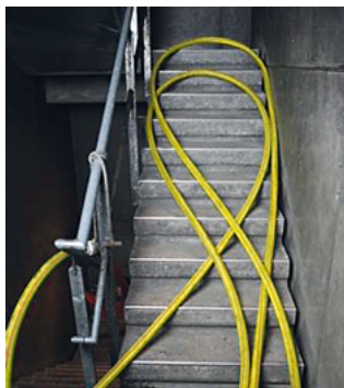
Abb. 25 Verlegen der Schlauchreserve im Innenbereich
