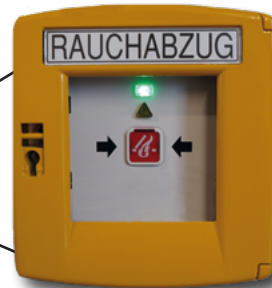
Abb. 19 Rauch- und Wärmeabzugsanlage (RWA)
