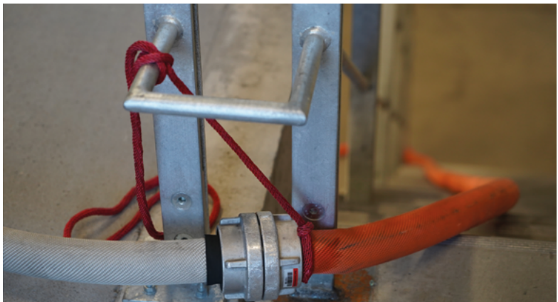
Abb. 24 Sichern der Schlauchleitung
